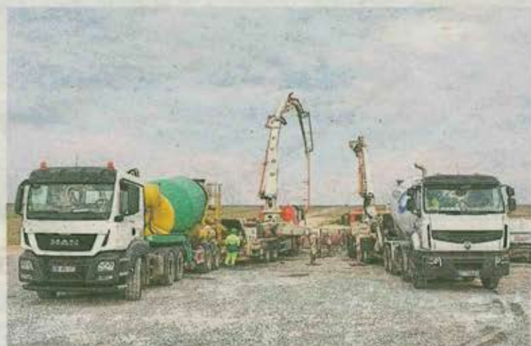
Arrivés sur le chantier, les poids lourds déversent leur béton dans des camions pompes.
