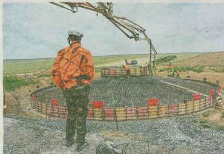
Deux ouvriers dirigent les pompes à béton à l'aide de joystick.
